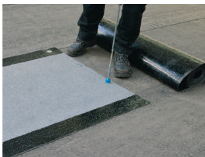
4. Fäst in rännalsvåden mekaniskt i underlaget.
