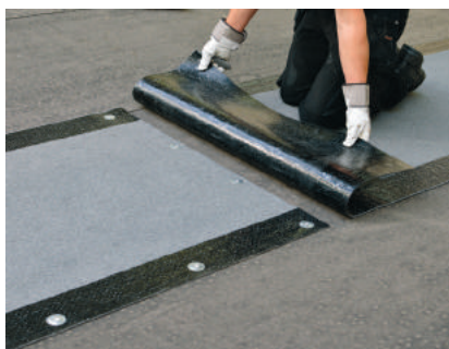
5a. Anslut nästa rännalsvåd mot brunnsintäckningen. Överlappa och svetsa 300 mm.
