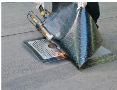
2. Montera rännalsvåd 1 x 1 m över brunnen.
