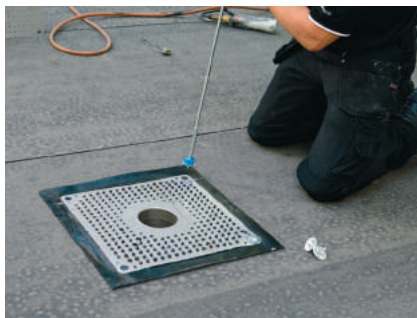
1. Placera brunnen och fäst in brunns alla fyra hörn i underlaget.
